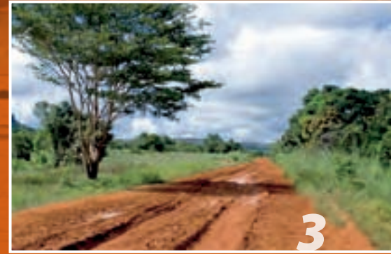
3 بناء طرق مؤقتة لوضع المصنع في المكان الذي نحتاجه.
